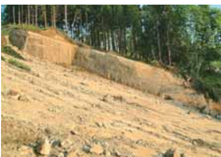
全国の災害現場へ向かい調査を行う。写真は中越地震の調査で訪れた小千谷市横渡の地滑り
