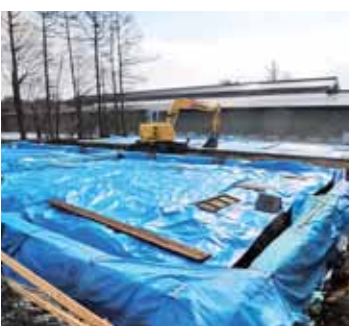
「まほろん」内に建設中の仮保管施設
