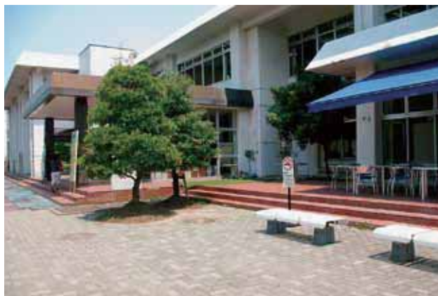
大 学 会 館 University Refectory
