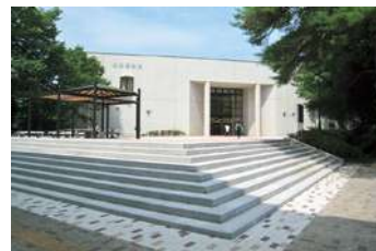
フクニチャージ図書館(附属図書館) FUKUNICHARGE LIBRARY (University Library)
