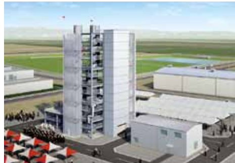
福島ロボットテストフィールド 試験用プラント
