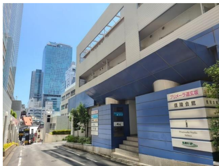
▲福島大学東京連絡事務所（外観）
