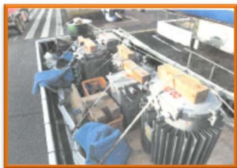
低濃度PCB搬出状況
