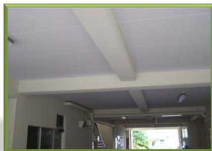
(体育館通路天井)アスベスト除去後
