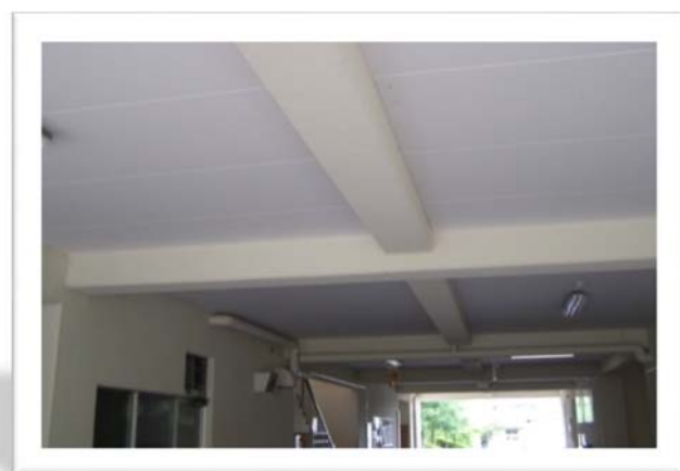
(体育館通路天井)アスベスト除去後
