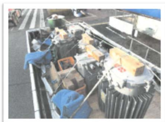
低濃度PCB搬出状況
