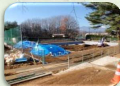
ハンドボールコートトレンチ
