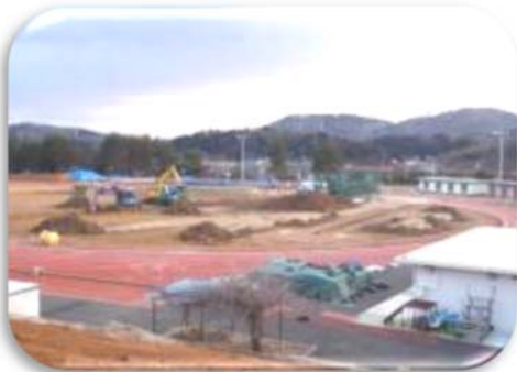
陸上競技場表層土除去(芝張替含)
