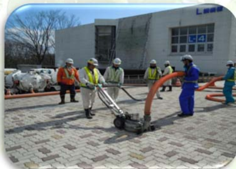
超高压水洗浄による中央広場除染
