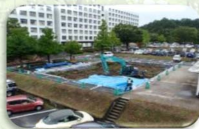
埋設保管用トレンチ
