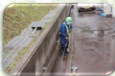
側溝の洗浄
