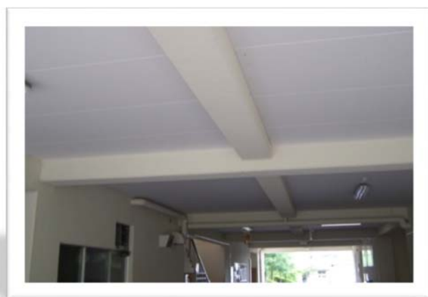
(体育館通路天井)アスベスト除去後
