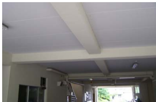
(体育館通路天井)アスベスト除去後
