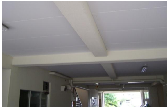
(体育館通路天井)アスベスト除去後
