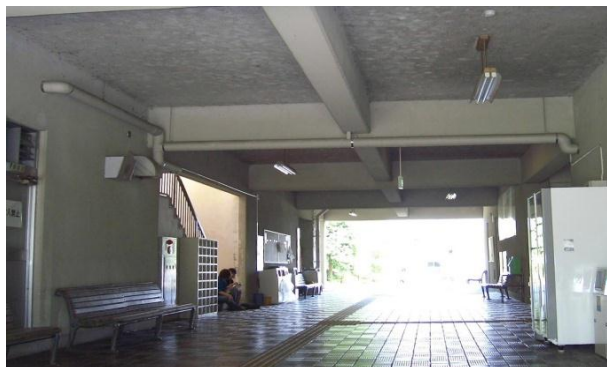
(体育館通路天井)アスベスト除去前
