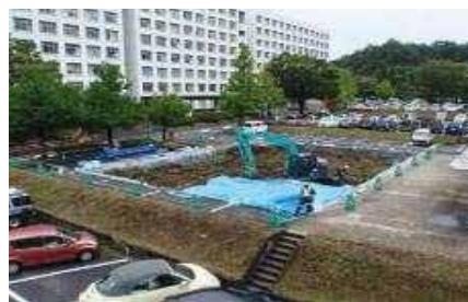
埋設保管用トレンチ
