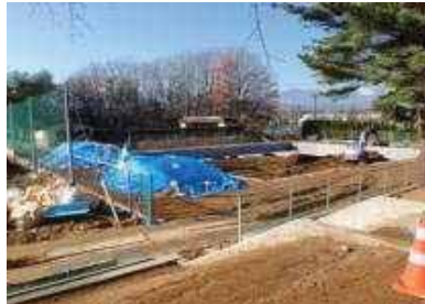
ハンドボールコートトレンチ
