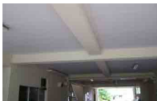
(体育館通路天井)アスベスト除去後
