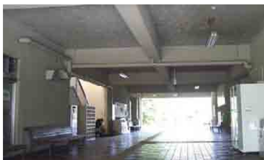
(体育館通路天井)アスベスト除去前
