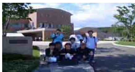
すりかみ浄水場
