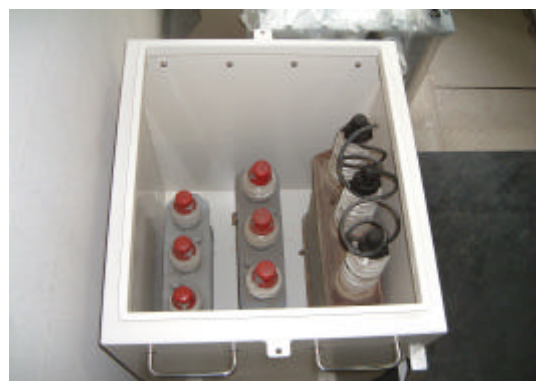
PCB保管箱 内部)
