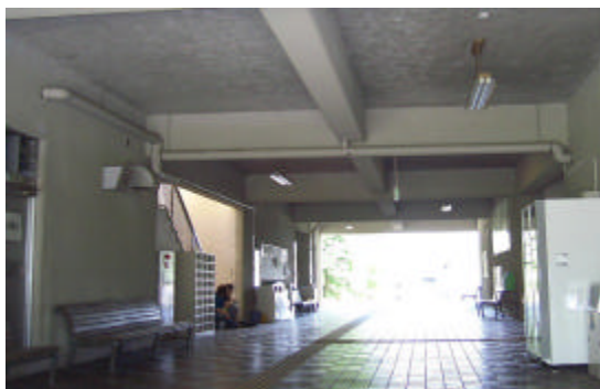
体育館通路天井)アスベスト除去前
