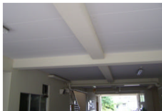
体育館通路天井)アスベスト除去後
