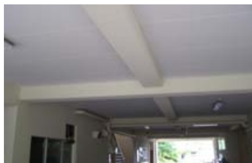
(体育館通路天井)アスベスト除去後
