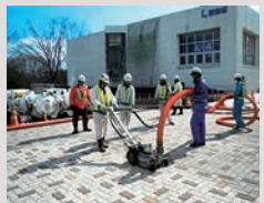
中央広場インターロッキング舗装面除染工事
