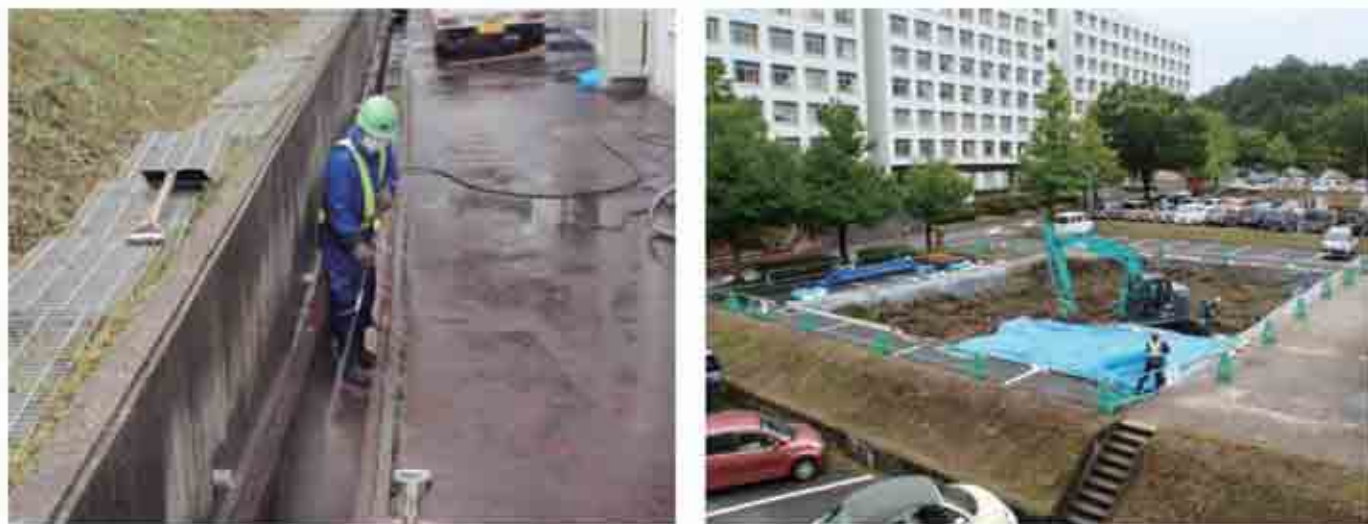
写真は側溝の洗浄(左)とトレンチへの埋設(右)
