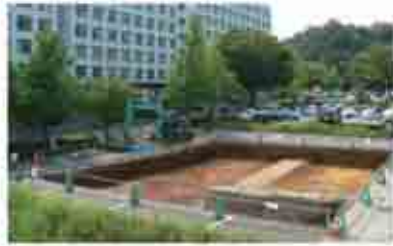
除染作業(トレンチ掘削)
