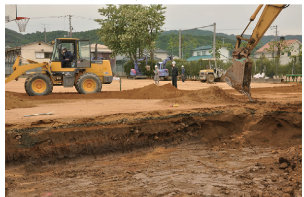
除去した表土を敷地内トレンチに埋設
