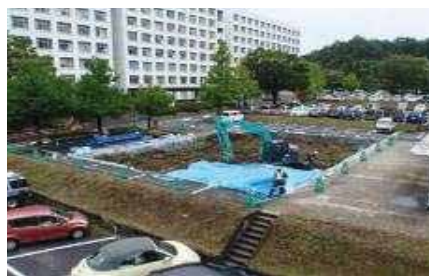
埋設保管用トレンチ
