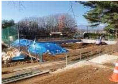
ハンドボールコートトレンチ
