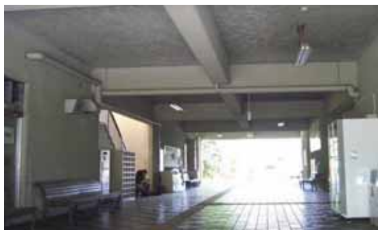
(体育館通路天井)アスベスト除去前
