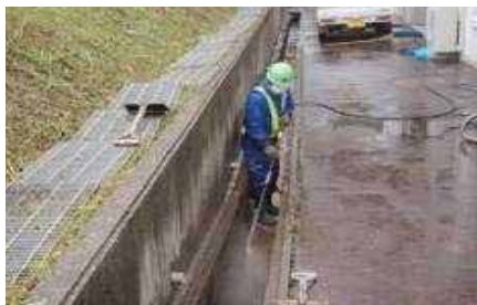
側溝の洗浄
