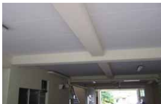
(体育館通路天井)アスベスト除去後
