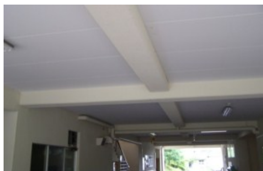
(体育館通路天井)アスベスト除去後
