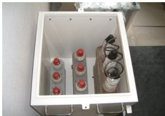
PCB保管箱(内部)
