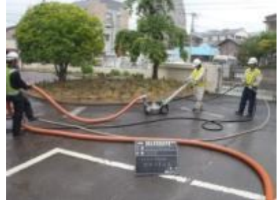
正門アスファルト舗装超高压水洗浄除染
