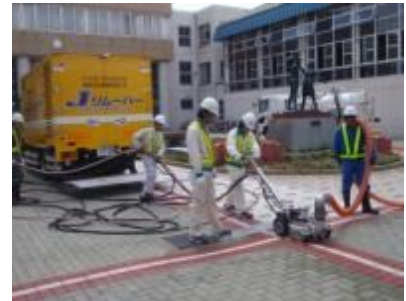
玄関前インタ-ロッキング広場超高压水洗浄除染
