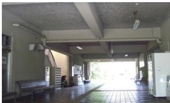
(体育館通路天井)アスベスト除去前
