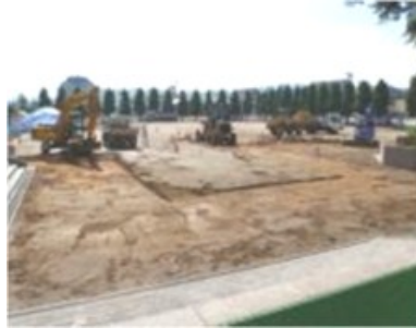
玄関前インタ-ロッキング広場超高压水洗浄除染
