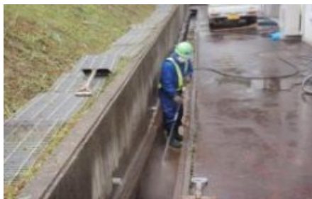
側溝の洗浄
