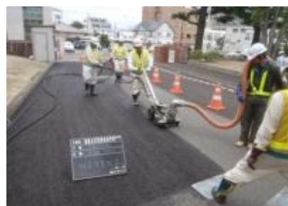
正面口-タリ-アスファルト舗装超高压水洗浄除染
