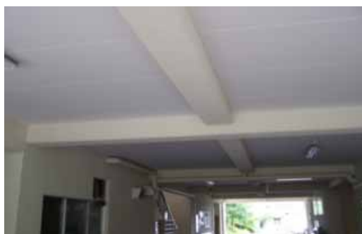
(体育館通路天井)アスベスト除去後
