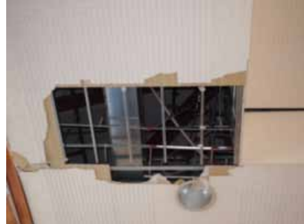
天井材落下状況 (附属小学校あおい広場)
