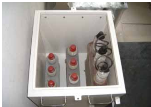
PCB保管箱(内部)
