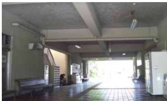
(体育館通路天井)アスベスト除去前
