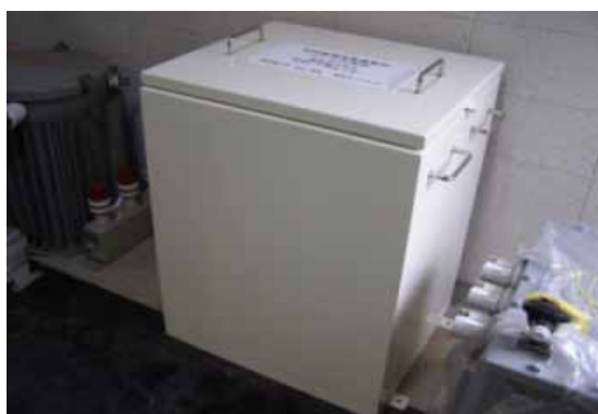
PCB保管箱(外部)
