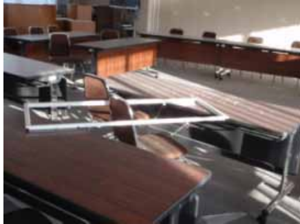
照明器具落下状況 (金谷川キャンパス本部管理棟大会議室)
