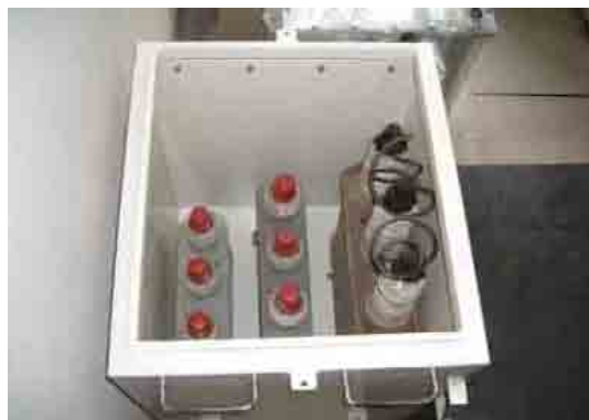
PCB保管箱(内部)
