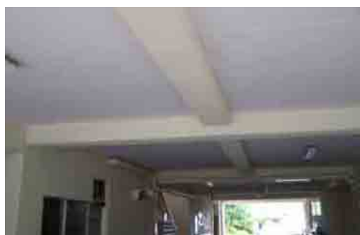
(体育館通路天井)アスベスト除去後
