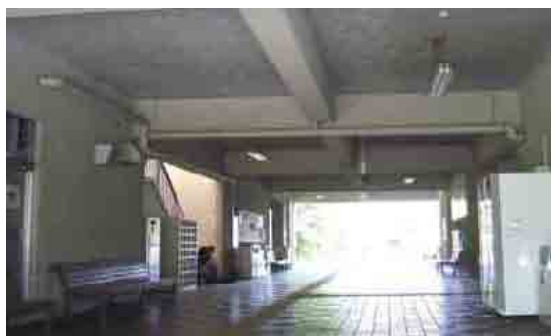
(体育館通路天井)アスベスト除去前
