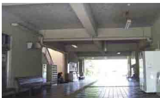
(体育館通路天井)アスベスト除去前
