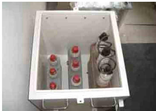
PCB保管箱(内部)
