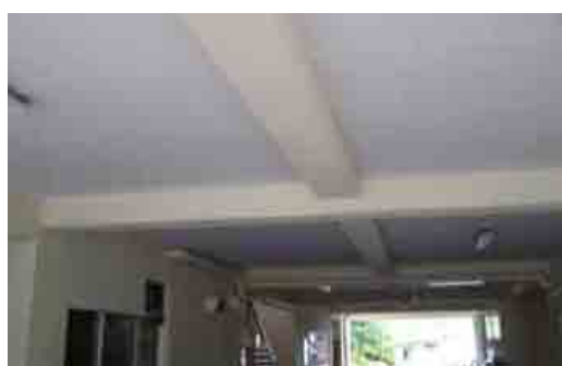
(体育館通路天井)アスベスト除去後
