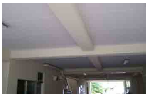
(体育館通路天井)アスベスト除去後
