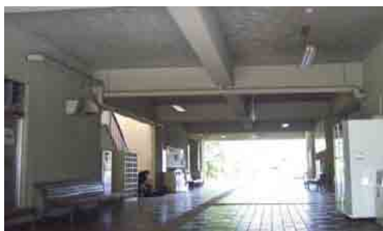
(体育館通路天井)アスベスト除去前
