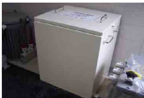
PCB保管箱(外部)
