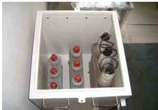
PCB保管箱(内部)
